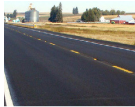
Install Edge Line Rumble Strips / Stripes
