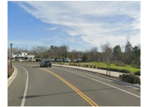
Install Edge Lines & Centerlines
